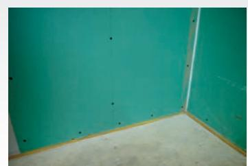
При необходимости поверхность панельной системы дополнительно выравнивается под финишную отделку.
