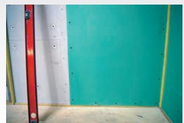
При монтаже гипсокартонных листов используются саморезы 3,9x41 мм. Саморезы не должны попадать на виброузлы сэндвич-панелей. Шаг саморезов по вертикали составляет 200 мм, по горизонтали – 400 мм.
