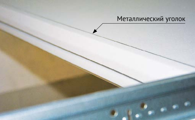
Вариант монтажа за врезанный уголок
