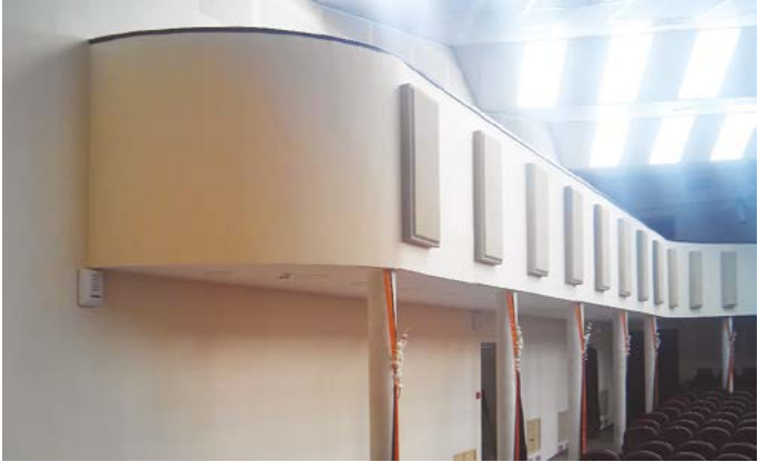
Корректировка акустики концертного зала по НЧ
