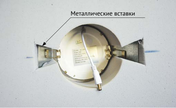
Армирующие вставки для монтажа светильников
