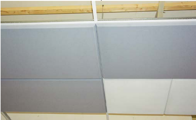
Фаска на потолочных панелях скрытого монтажа
