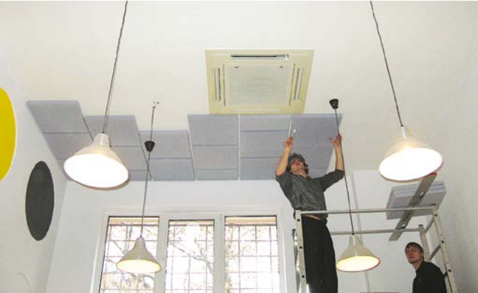
Монтаж на клей потолочных панелей
