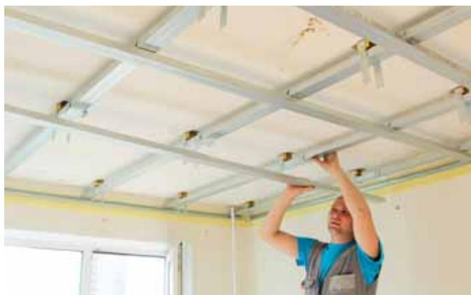
Комплексное применение вышеуказанных материалов в сочетании с общестроительными элементами и технологиями (листы ГВЛ, ГКЛ, металлический каркас типа Knauf) при соблюдении технологии монтажа позволяет получить звукоизоляцию на 10-15 дБ выше, чем у аналогичной конструкции без применения специализированных акустических материалов.
